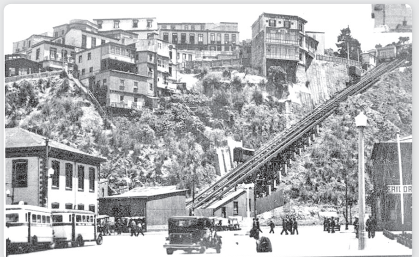
Vista panorámica de la aduana, donde se ubica una pequeña plaza.
